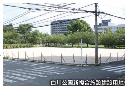
白川公園新複合施設建設用地
