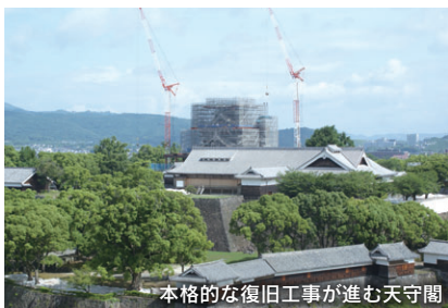
本格的な復旧工事が進む天守閣
